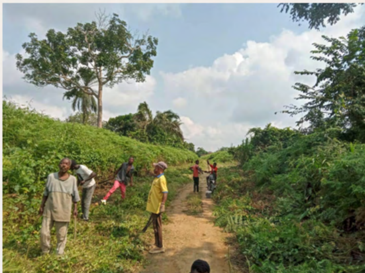
Nous avons déblayé une route secondaire qui relie les deux quartiers.
