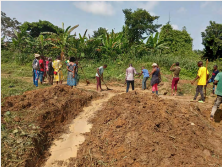
Nous avons désengorgé le marécage qui empêchait le passage pour aller dans la communauté autochtone de Bambama.
