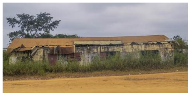
État du bâtiment avant réhabilitation
